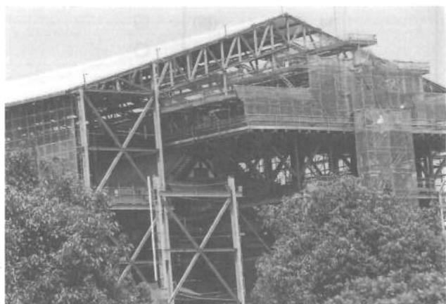
〔写真4〕鉄骨の覆屋解体作業・大極殿の上層部を望む
